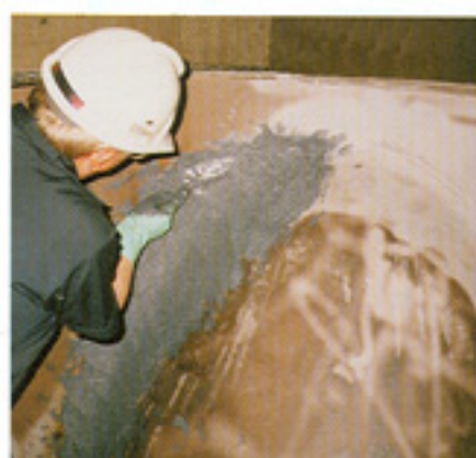
Wear Guard™ High Temp es 30% más resistente a la abrasión que los compuestos antidesgaste convencionales en aplicaciones de alta temperatura.
