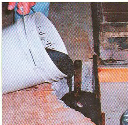
Deep Pour Grout™ tiene una alta resistencia a la compresión y es ideal para fijar los bulones de anclaje de las máquinas.
