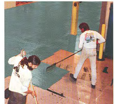
Epoxy Coat™ 7000 non VOC es un revestimiento 100% sólidos que puede aplicarse con rodillo, sobre pisos de concreto uniforme o levemente resquebrajado para darle un acabado atractivo y fácil de mantener.
