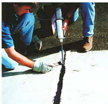
El Flexane® Fast Cure Liquid es un uretano líquido de baja viscosidad y curado rápido para rellenar juntas de control/expansión en metal o concreto.
