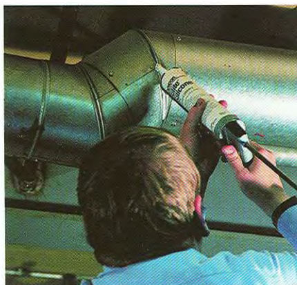
Silite® Silicone fragua a la consistencia de un material similar al caucho flexible que no se agrieta ni encoge y es ideal para sellar conductos de calefacción/aire acondicionado.
